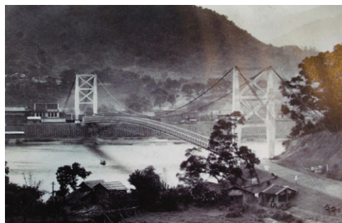
碧潭是台灣最長，也是僅存的鎢鋼球軸承吊橋。新北市不列入古蹟保護，竟然破壞76年文化資產！
